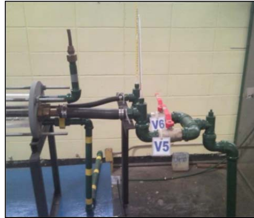
Figura 4. Zona de descarga
