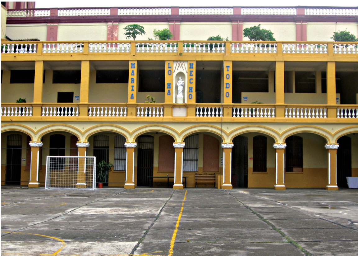
Figura 2. Interior del claustro de San Jorge, Ibagué
