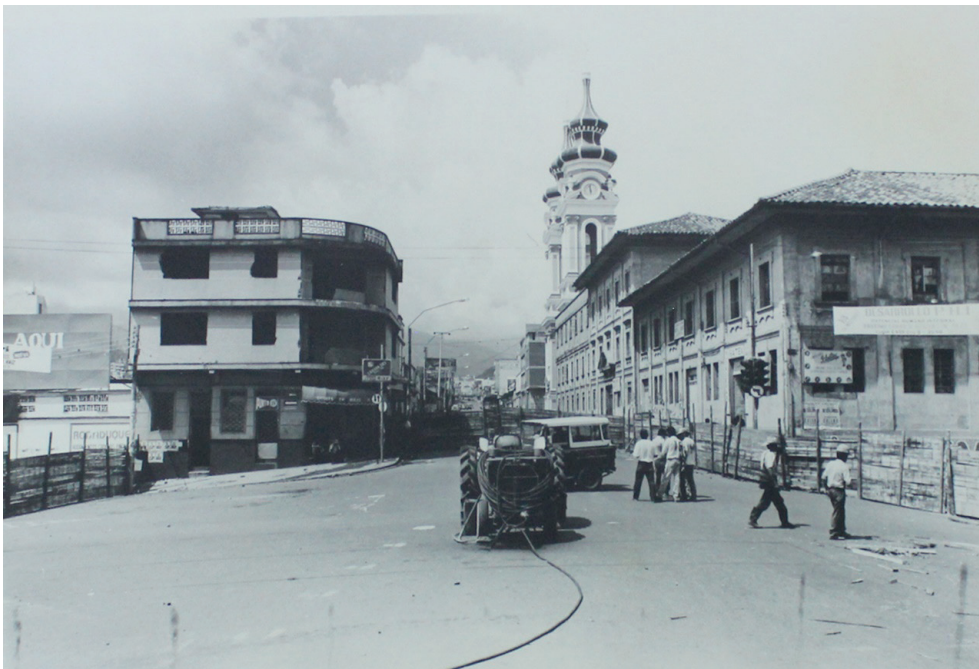
Figura 7. Claustro San Jorge a la derecha, con las cúpulas de la Iglesia del Carmen al fondo
