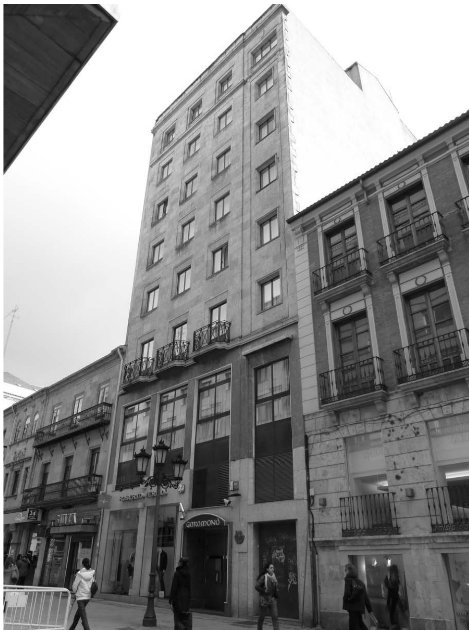
Fig. 2. Edificio promovido por Francisco Gil González. Francisco Gil González. 1957. Calle Toro n° 64. Salamanca.
