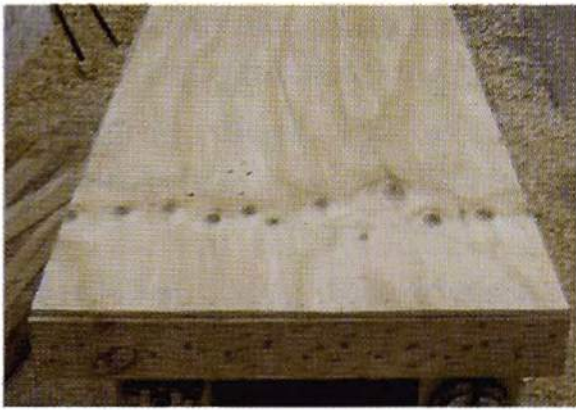
Variante 1: Refuerzo con placa
