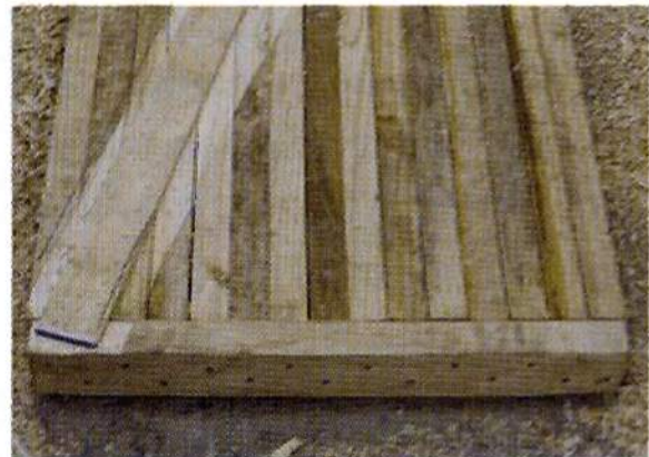
Variante 2: Refuerzo con diagonal
