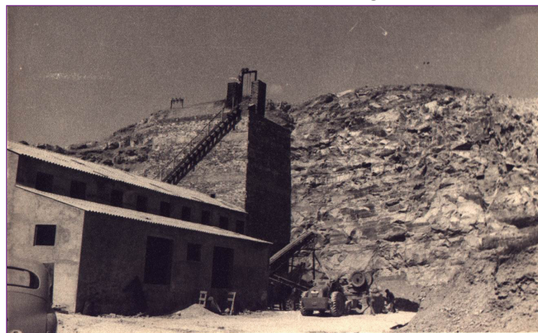
Figura 02: yacimiento y fábrica de cemento natural en Martos (Jaén); todavía en funcionamiento alrededor de 1960. Cortesía de D. Juan Ríquez Molina.
