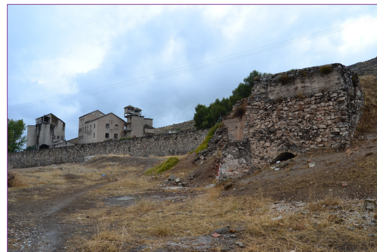
Figura 04: restos del horno de Atarfe (Granada) en la actualidad. Al fondo la antigua fábrica de cementos “Centauro”.
