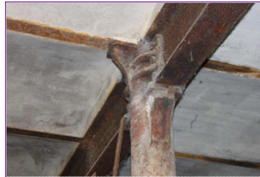
Fig. IV. Fotografía de unión de pilar de fundición con viga de hierro doble T
