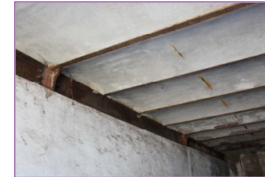
Fig III. Fotografía de forjado con revolton cerámico
