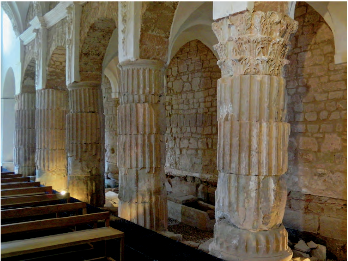
Fig. 7. Columnas y capiteles del templo forense reutilizadas en la basílica de Santa María de los Arcos. Fotografía: Luis Romero Novella.
