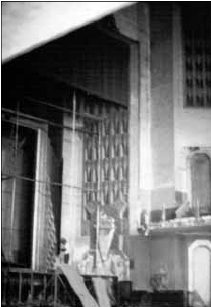
Fig. 27. Embocadura de la pantalla, durante su destrucción, 1981 (JMSC).
