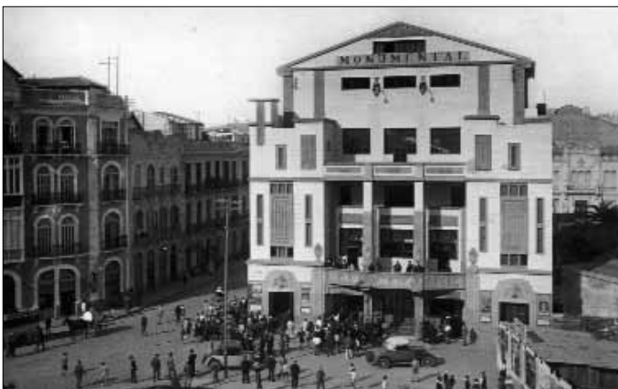
Fig. 17. Fachada principal del Monumental, años treinta.
