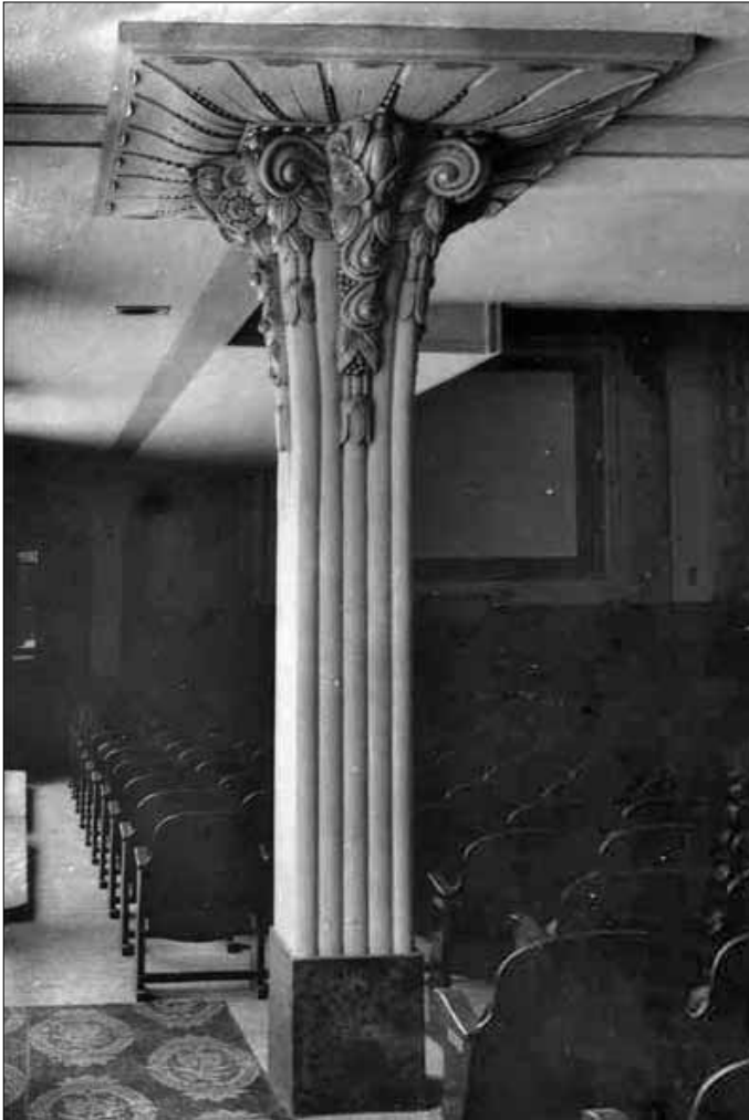
Fig. 16. Detalle de la columna, 1932 (ACM).
