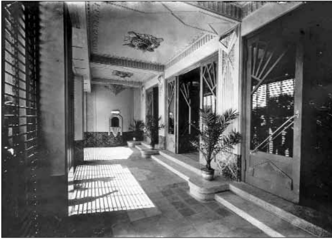
Fig 5. Vistas de la zona de taquillas y puertas de entrada, 1932 (ACM).
