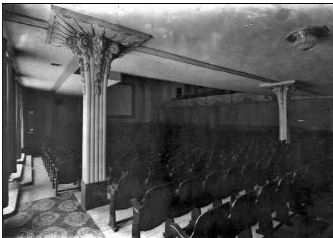
Fig. 15. Detalle de columna zona de butacas, 1932 (ACM).
