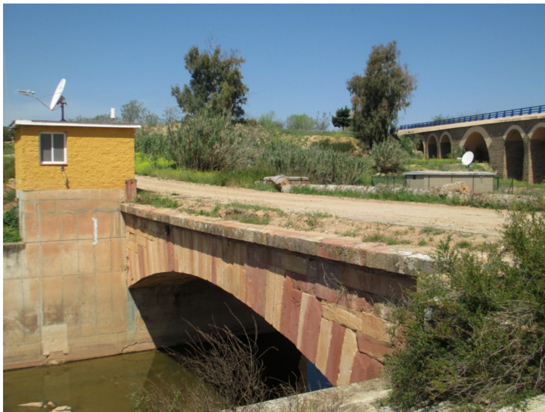
Vista desde el oeste. Los dos puentes se siguen utilizando en la actualidad, aunque el más antiguo solamente para paso de vehículos agrícolas. Foto M. Roll.
