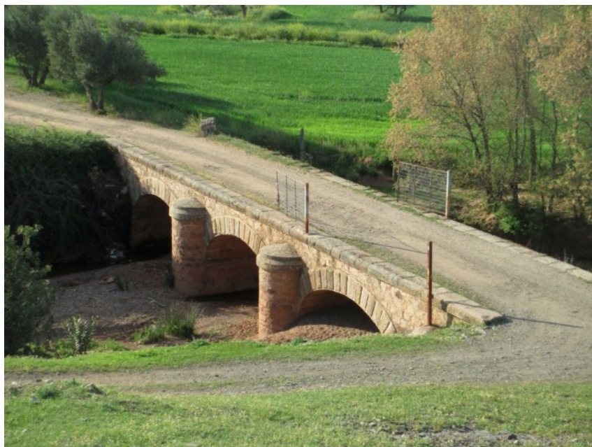
Puente sobre el río Guadiel en el km 14 de la línea. Foto M. Roll.
