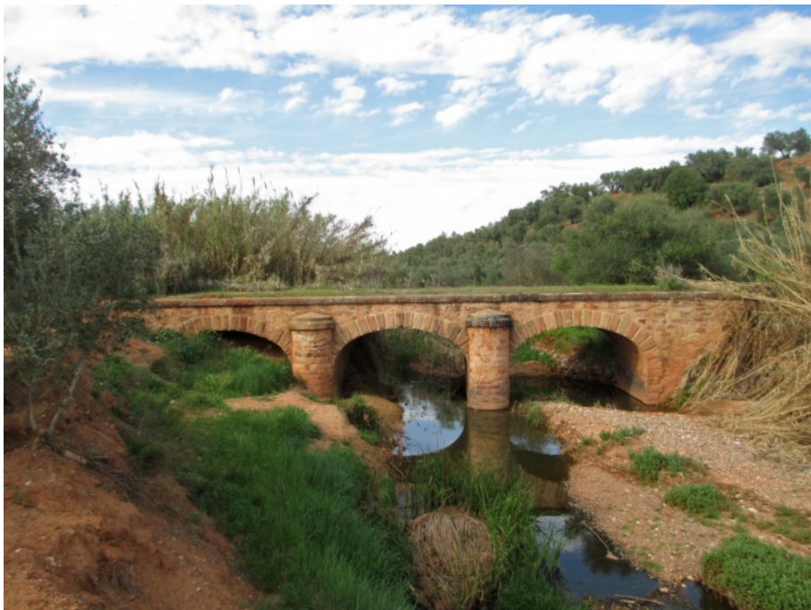
Vista del puente, aguas abajo del arroyo de las Pilas, en el km. 16 de la línea. Foto M.Roll.
