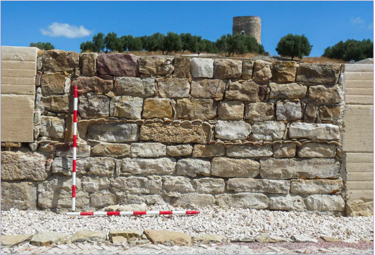
Figs. 2-3. Muro de cierre del Pórtico Sur: bloques de piedra caliza local y opus vittatum.
