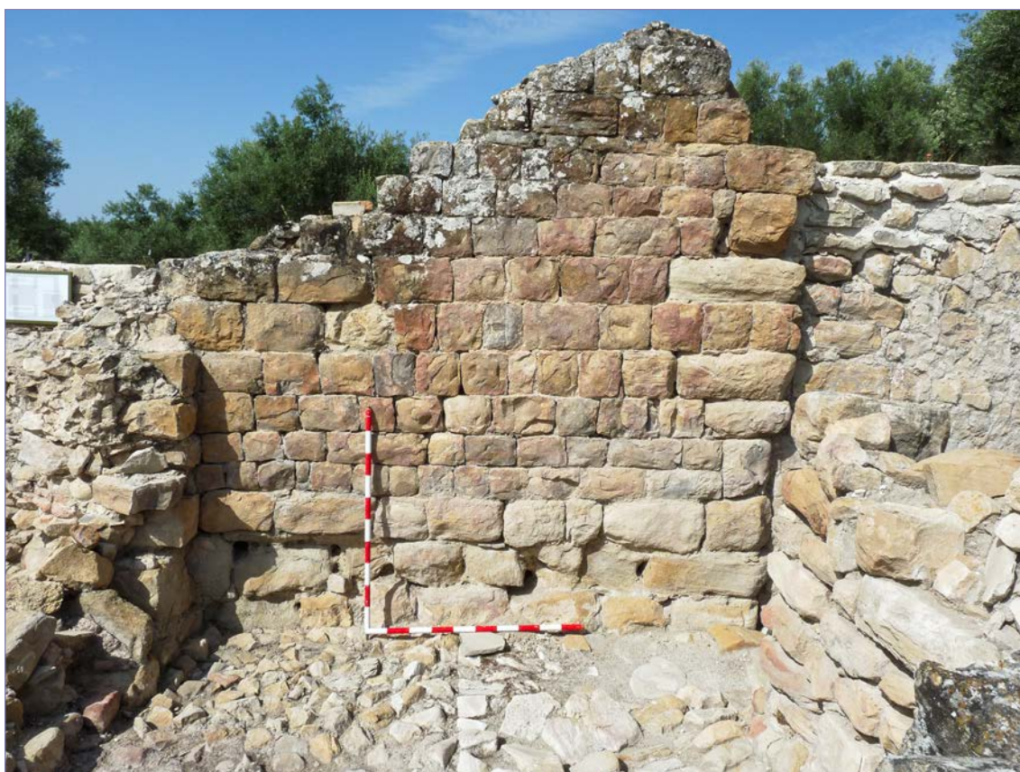
Fig. 9. Alzado de muro conservado en opus vittatum .
