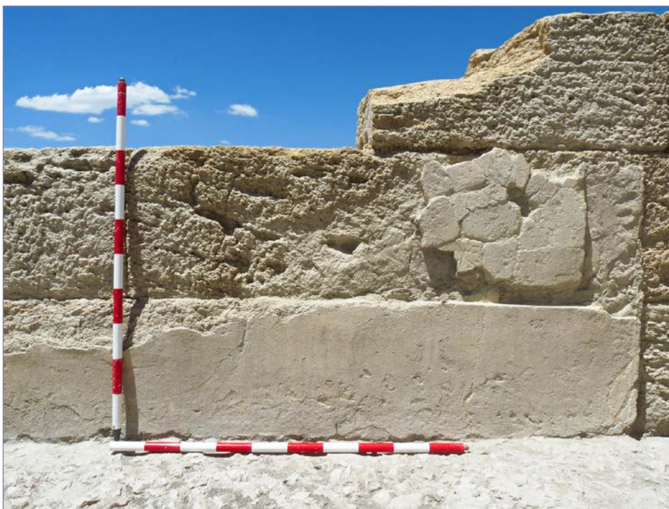
Fig. 4. Muro Oeste del aula de la Curia, con revestimiento de estuco.
