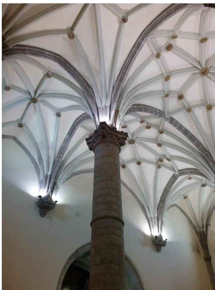
Pilar y bóvedas. Iglesia de Los Santos
