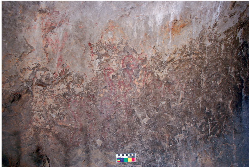
Lám. 3: Situación y estado actual del Panel 1.
