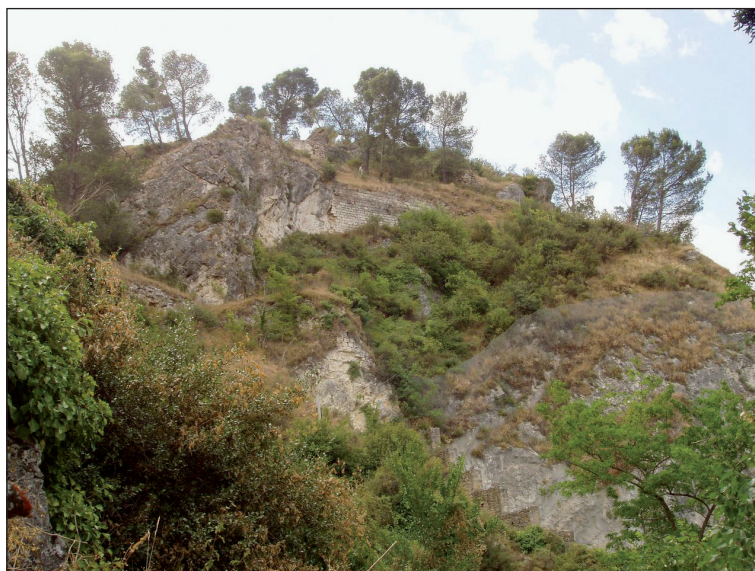
Figura 23. Tramos de muralla en dos niveles en la cara oeste de la peña.
