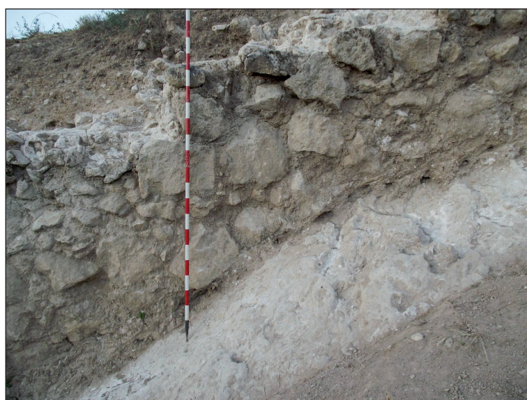
Figura 14. Detalle constructivo del muro que cierra el recinto de Lizarrara por el sudeste.
