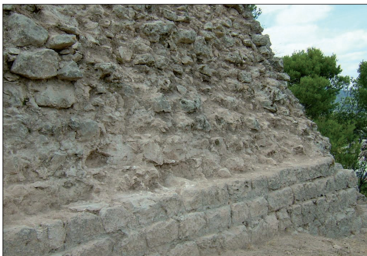
Figura 28. Parte baja del muro ataluzado.
