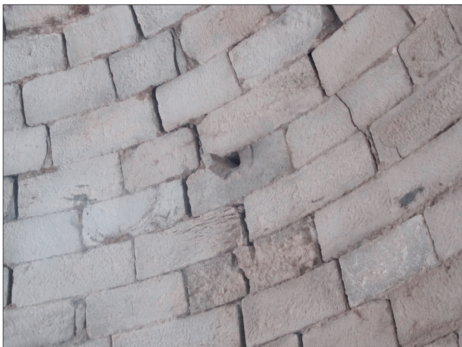
Figura 8. Caño vertedor fragmentado.
