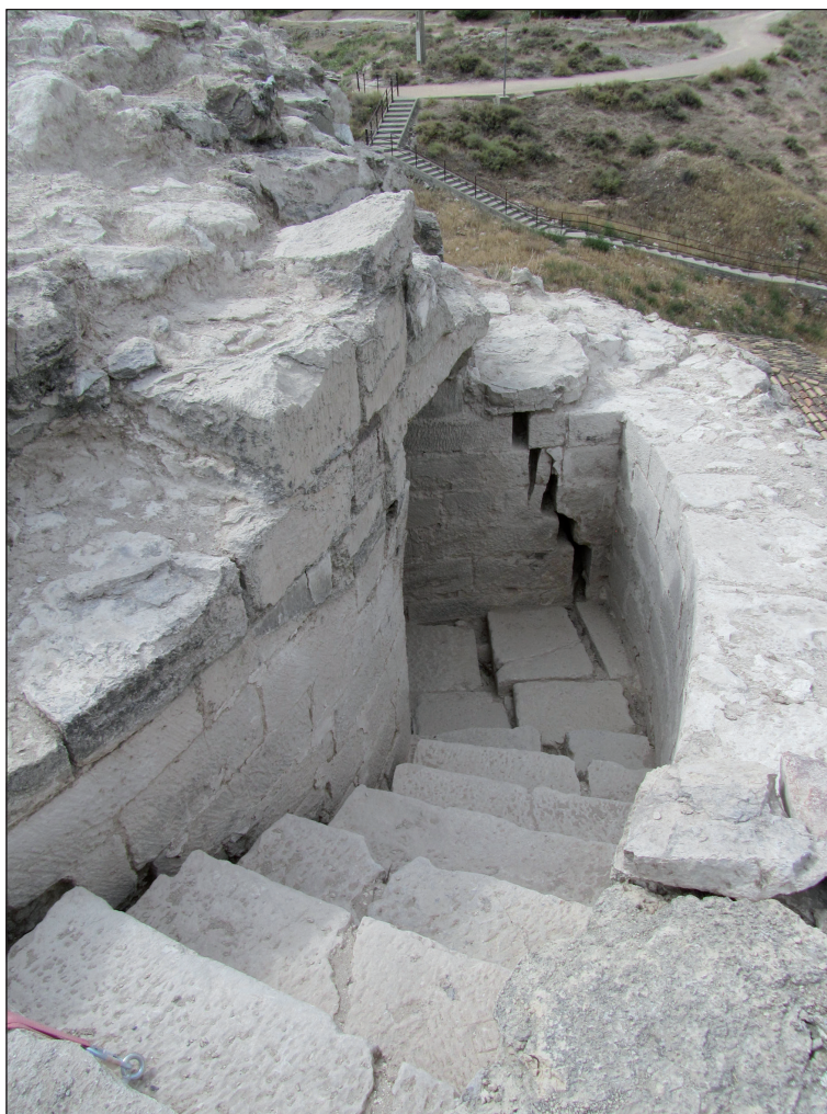
Figura 3. Escalera interna de comunicación entre plantas.
