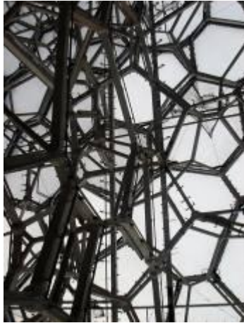
Figura 14: Foto da estrutura do Cubo D'água. Fonte: Http://www.core.form-ula.com/wp-content/uploads/2008/06/484440654_ee7bb8ddbc_b.jpg
