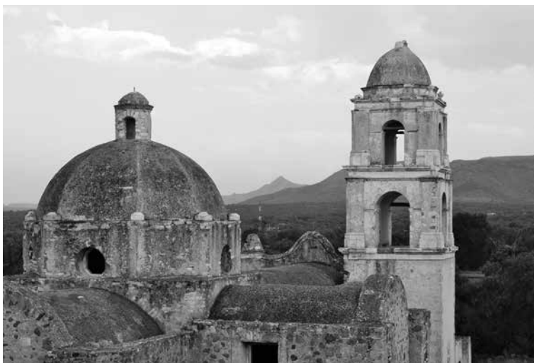
FIGURA 9. ACTUAL VISTA DE LA CÚPULA, LA TORRE Y LOS TECHOS DE BÓVEDA DE LA CAPILLA DE LA EXHACIENDA JESUITA LA PARADA
