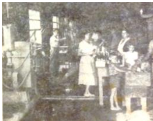
Pabellón de maquinaria al interior de la fábrica familiar de refrescos gaseosos Corrales en San Isidro del General.
