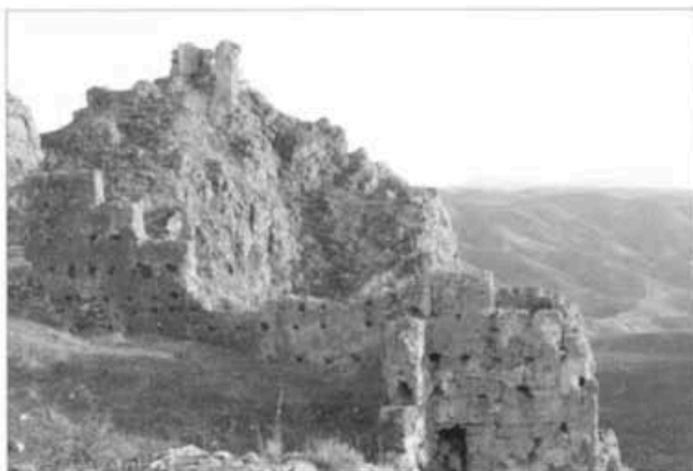
Perspectiva general del costado occidental desde el tercer recinto (inferior).
