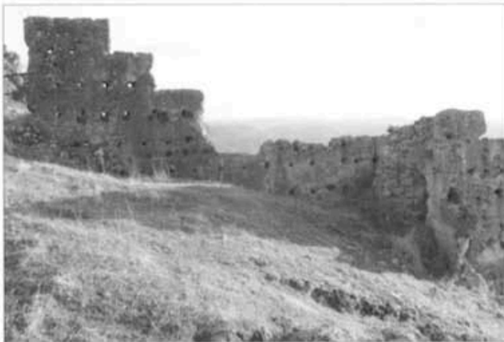
Lienzo de muralla del tercer recinto (zona occidental).
