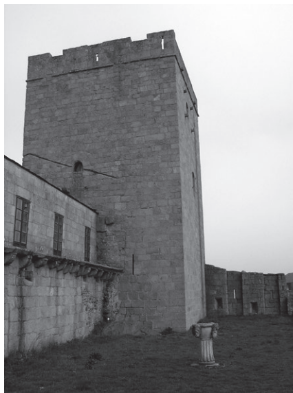
FIGURA 9 Torre noreste, llamada del Homenaje, adarve
