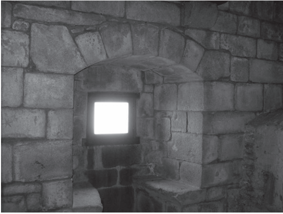
FIGURA 12 Poyo en el primer nivel de la torre oeste
