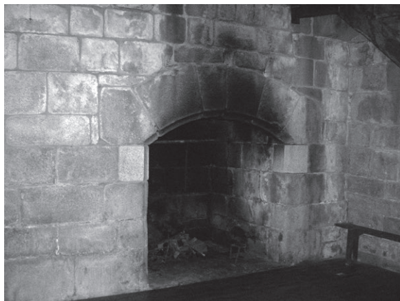
FIGURA II Chimenea en el primer nivel de la torre oeste
