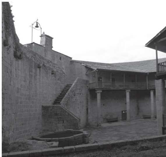
FIGURA 5 Patio de Armas: restos conservados en la zona meridional
