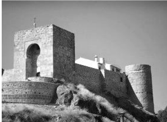
Figura 4. Puerta de Málaga
