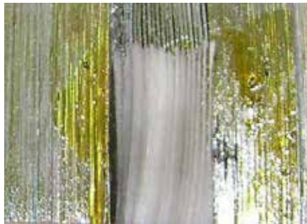
Figura 15. Detalle reparación parcial Fuente: elaboración propia
