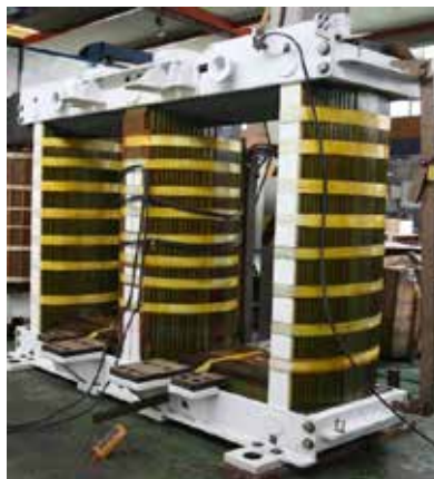
Figura 16. Núcleo con reparaciones parciales y barnizado Fuente: elaboración propia
