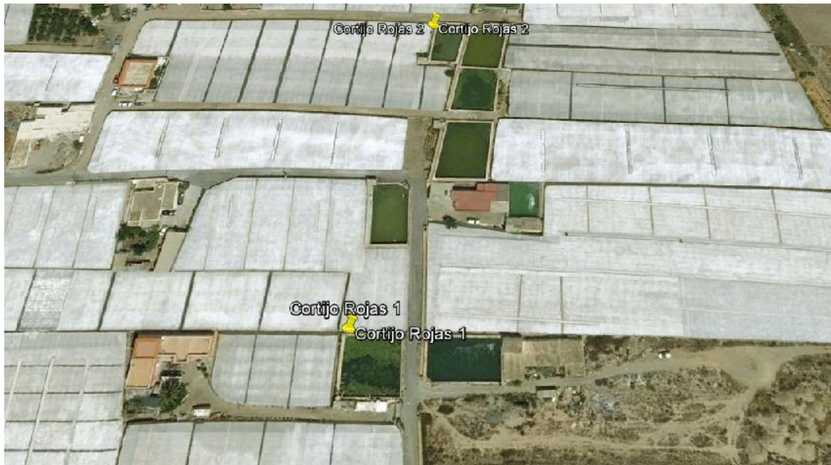
Figure 2. Distribution and appearance of ponds. Figura 2. Distribución y aspecto de las balsas.
