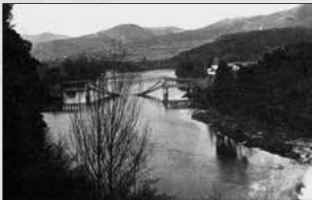
VALDUNO, EL PUENTE VOLADO. FOTO TOMADA POR LOS MILICIANOS DEL BATALLÓN VASCO. CEDIDA POR RAMÓN DUARTE
