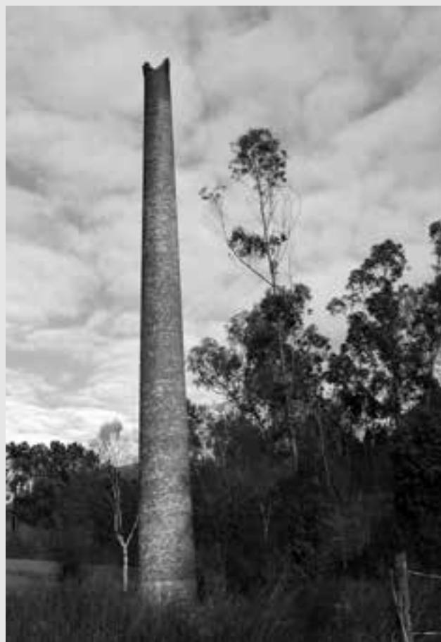
RUINAS DE LA FÁBRICA DE LA SIERRUCA, NOVIEMBRE 2014. FOTO DE L. CARLOS VILLANUEVA
