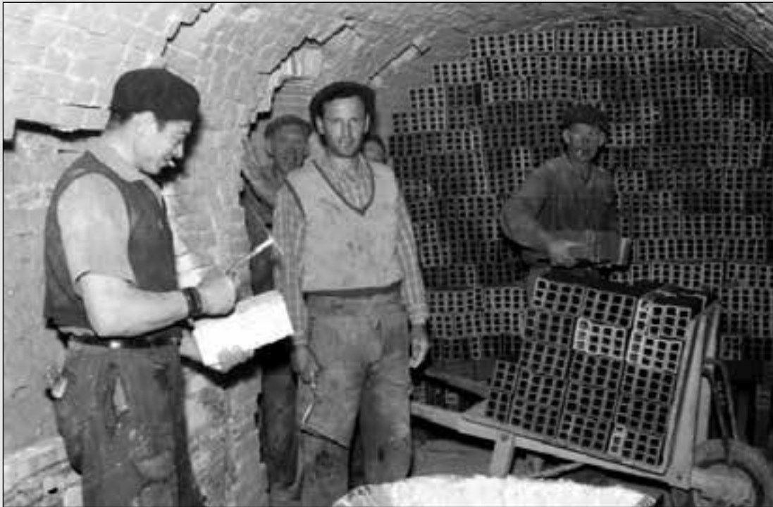
INTERIOR DEL HORNO DURANTE LAS TAREAS DE CARGA DE UN SECTOR HOFFMANN. FOTO JOSÉ M a GONZÁLEZ VILLANUEVA
