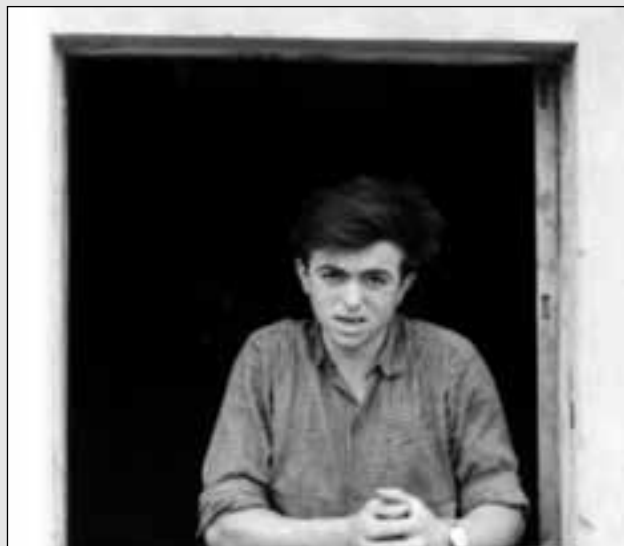
TRABAJADOR EN UN BARRACÓN. FOTO JOSÉ M a GONZÁLEZ VILLANUEVA
