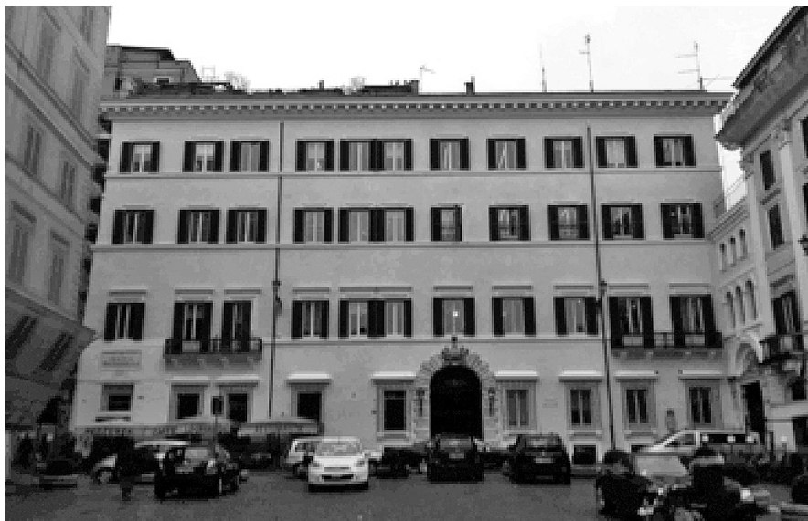
Ilustr. 3.- Fachada del Palazzo Gabrielli-Mignanelli, hoy Valentino, Roma (tras su limpieza y restauración en 2015)
