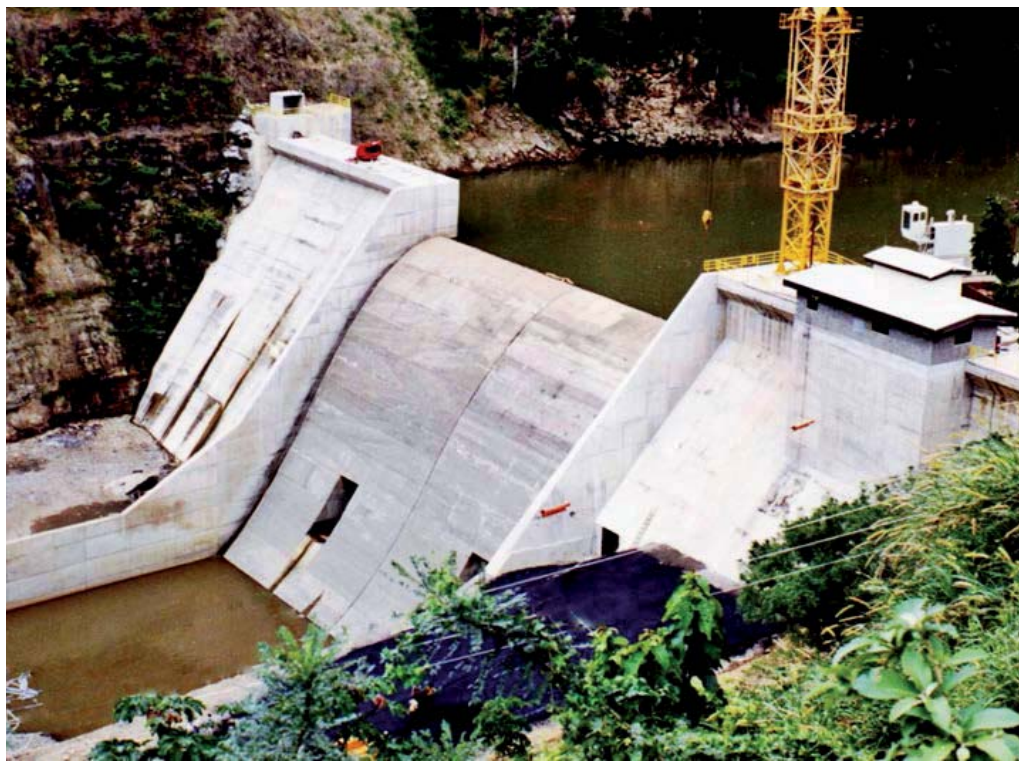
A. Baltodano. Planta hidroeléctrica Brasil
