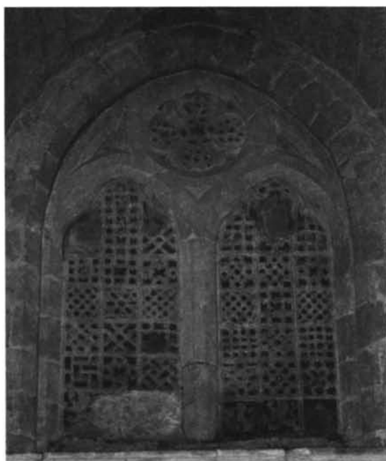
Foto 2: Celosía de yeso sobre la puerta del claustro en el último tramo de la nave izquierda.
