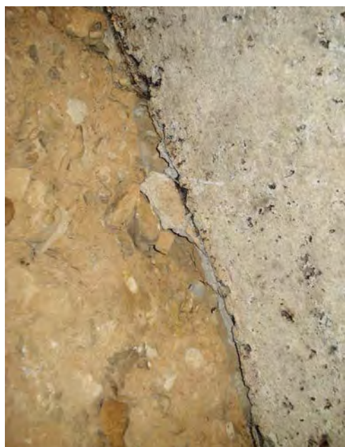
Foto 17. Restes de l'arrebossat que es col·loca a l'interior de la paret de l'arc de la nau.
