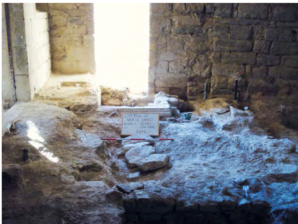
Foto 10. Restes del mur de tàpia damunt la porta romànica i com aquesta forada el mur de pedra de color negre.
