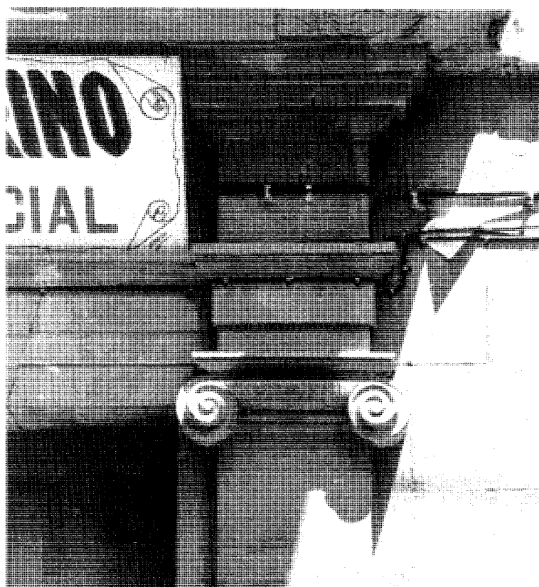
Fig. 14. Detalle de puerta principal.
