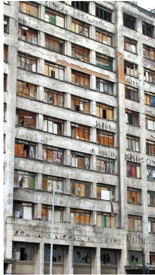
Fig.5. Natalia Echeverri A. 2012 Prédio no centro de São Paulo/SP, Brasil
