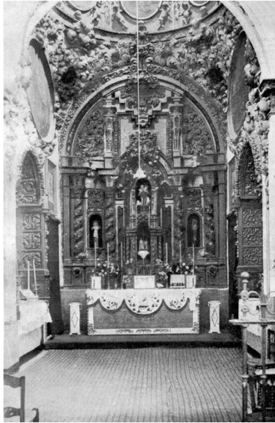
Fig. 1. Capilla del Buen Pastor antes de su destrucción en 1936. Convento de San Francisco, Vélez-Málaga (Málaga). Foto: Archivo Temboury.
