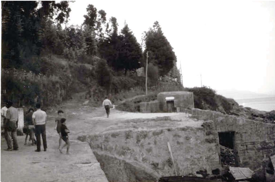
(Fig.3) Antiguos muros de piedra sobre los que se construyó la casa. Archivo Molezún
