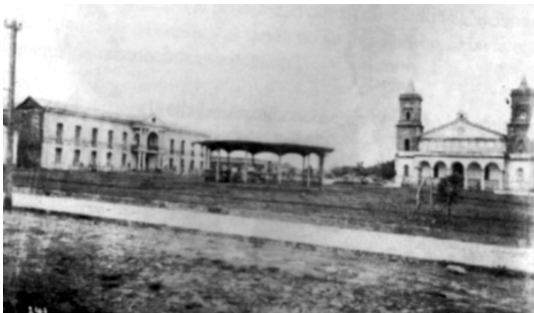
Figura 1. Palacio Municipal de San Ramón. (Año desconocido). Se puede notar que solo existían el templo católico y el quiosco en ese punto central de la comunidad. Finales del siglo XIX e inicios del siglo XX.
