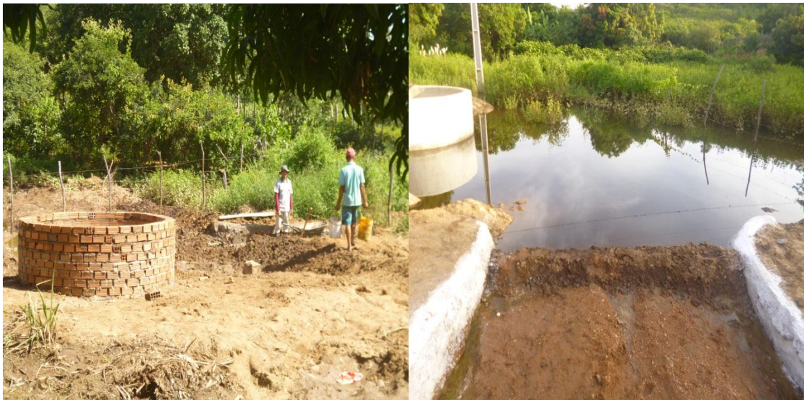
Figura 1. Barragem subterrânea e poço construído.
