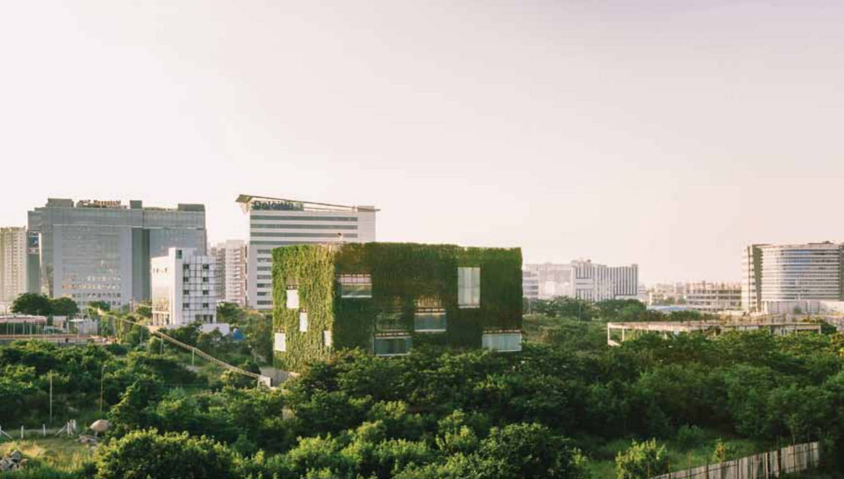
Entorno del edificio de oficinas.
