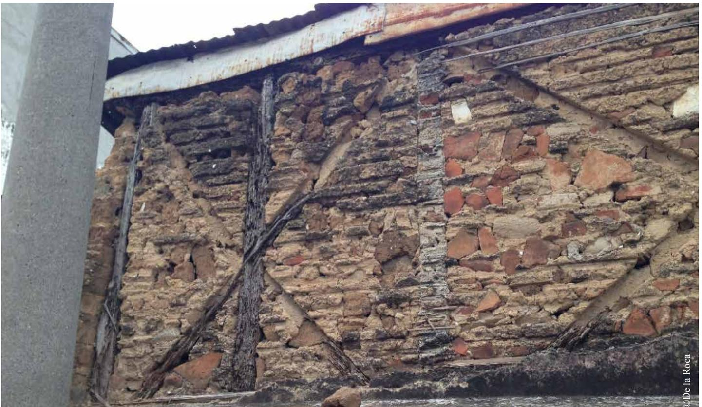
Figura 5. Detalle constructivo antiguo. Puede notarse que está pared construida con todo tipo de materiales de su época como adobes, barro cocido y piedra, reforzado con columnas y breizas de madera, está totalmente deteriorado (la madera estructural se destruyó por completo). En cualquier momento, con el menor esfuerzo sísmico este muro se perderá para siempre. Fotografía captada el 11-marzo-2016, autor Leonel Alberto De la Roca Coronado.
