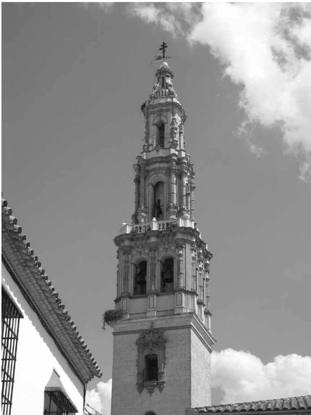
Torre de San Gil, comenzada en 1777 bajo las condiciones iniciales de José Álvarez. Finalizado el fuste, Antonio Caballero ejecutó los cuerpos superiores entre 1779 y 1782 en base a un alzado dibujado por él mismo, que interpretaba las prescripciones dadas por Antonio de Figueroa. Fotografía del autor.
