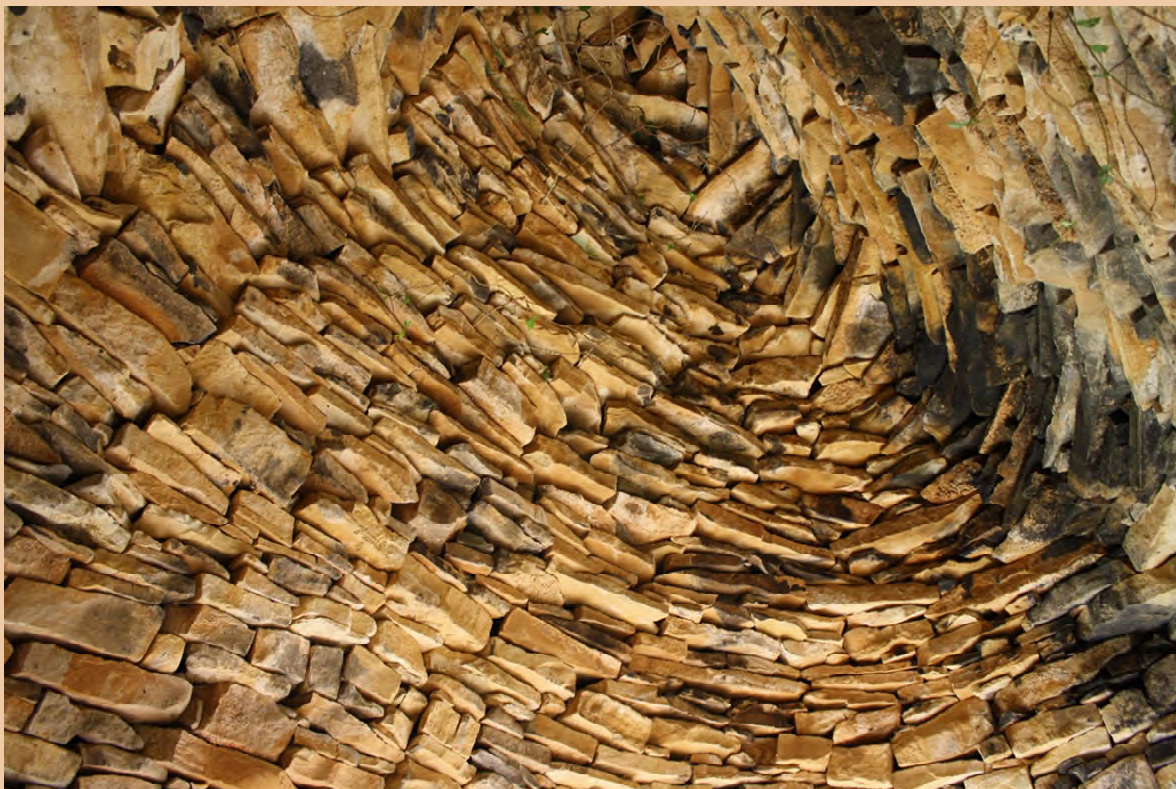
Detall d'una falsa volta.
