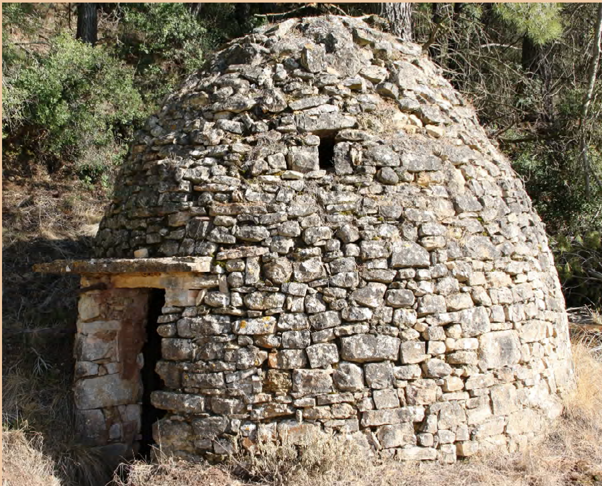
Bassot cobert amb la tècnica de la falsa volta. Solivella.
