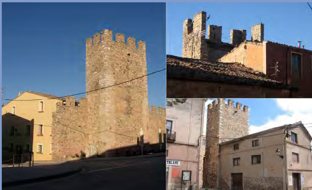
Imatge 11: Torres-vivendes que formen part d'un immoble annex.
