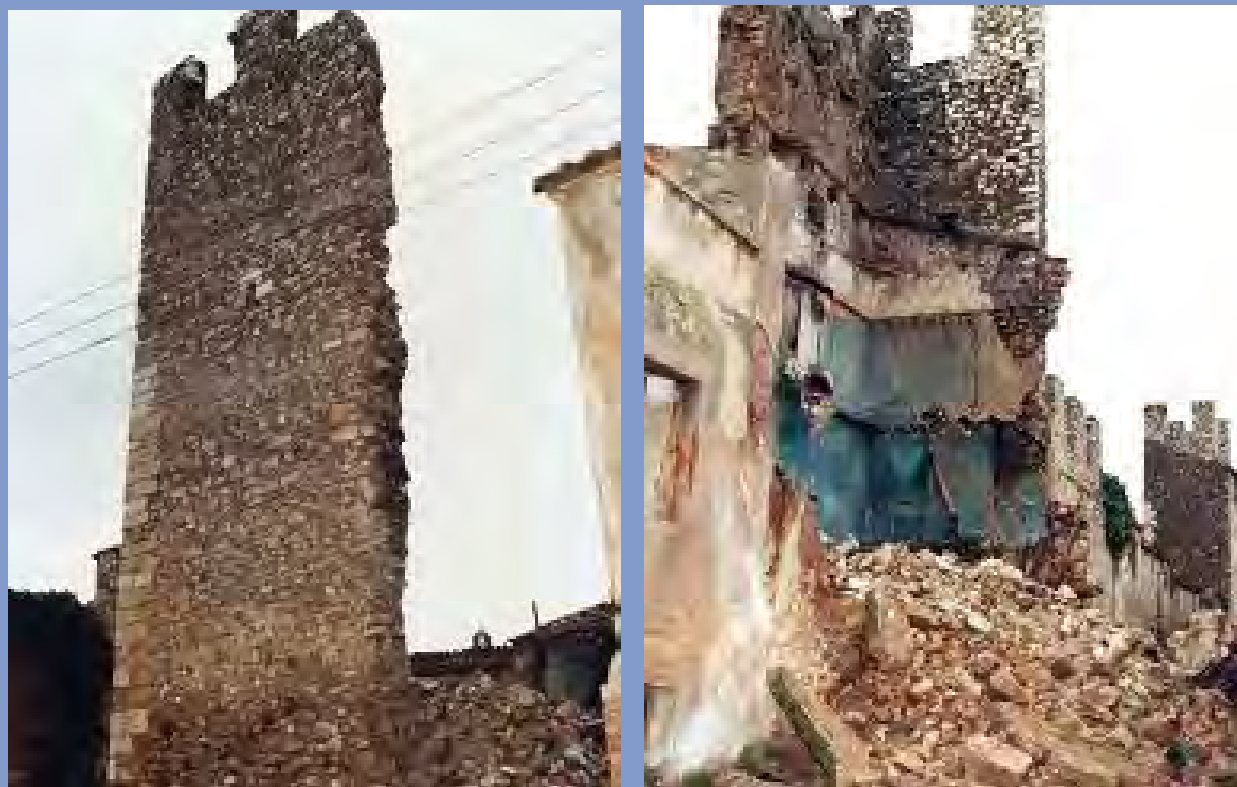
Imatge 8: Ensulada d'una torre a causa de l'aiguat de 1994.
