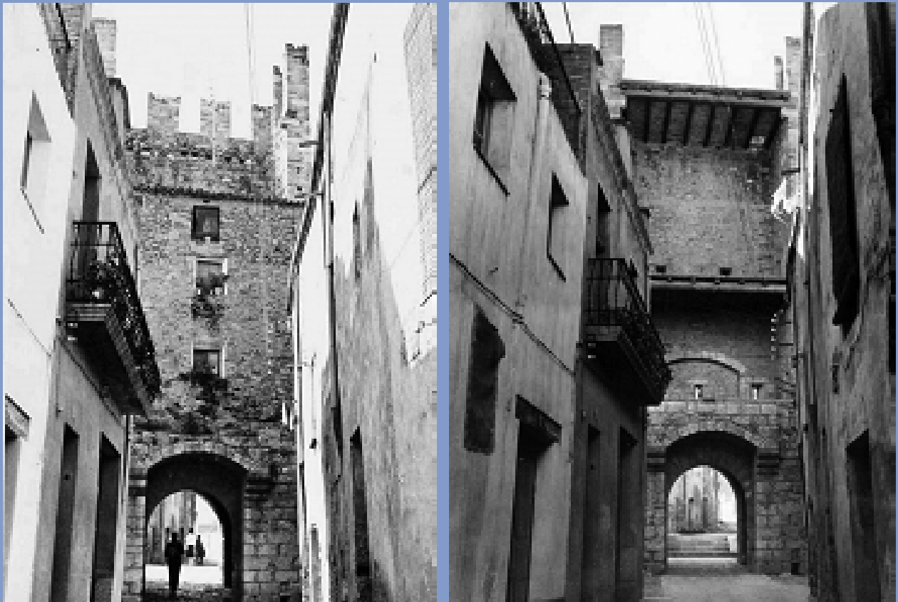
Imatge 7: Abans i després de les obres de la torre-portal de Sant Jordi (1967).
