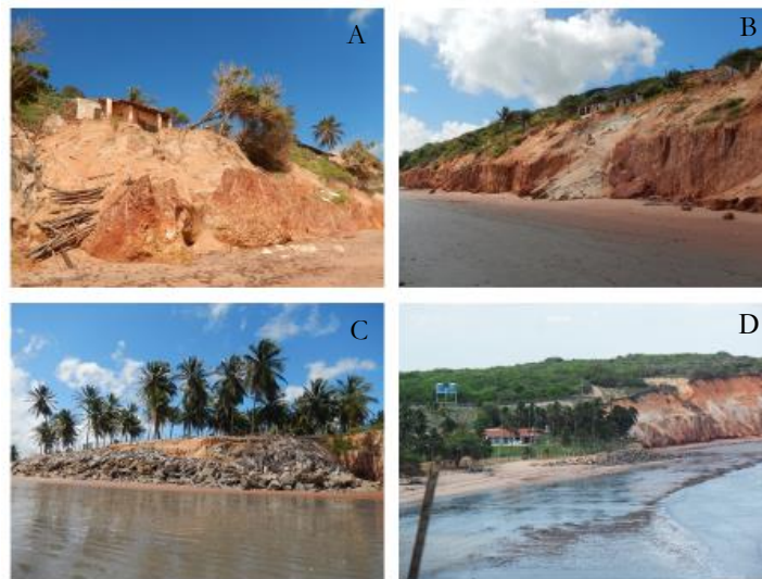
Figura 1. Mosaico de imagens dos efeitos da erosão costeira na praia de Retiro Grande em Icapuí: A) casa de veraneio abandonada em patamar de falésia e sinais de erosão; B) marcas de erosão pluvial em falésia; C) muro de pedras para controlar a erosão costeira; e D) fazenda Retiro Grande e estruturas de controle da erosão.
