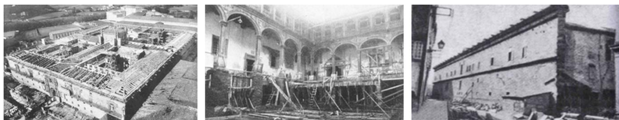
Figura 15: Vistas del Hospital Real de Compostela durante su rehabilitación.
