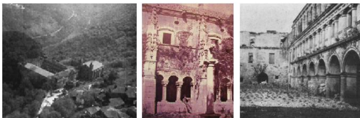
Figura 3: Vistas de Santo Estevo de Ribas de Sil antes de su rehabilitación.
