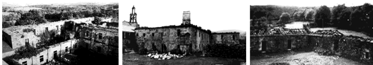
Figura 9: Vistas de Santa María de Aciveiro antes de su rehabilitación.
