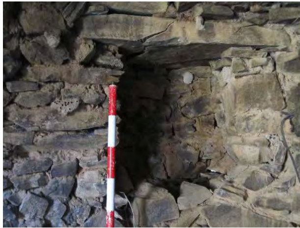
Figura 9: alacena de un solo anaquel realizada a partir de un rebaje en la pared del chozo.
