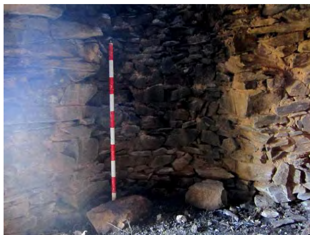
Figura 8: chimenea empotrada en la pared del chozo.
