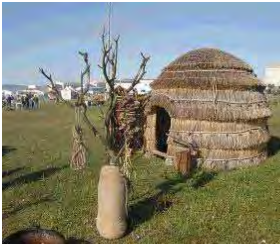
Figura 3: chozo móvil construido de bálago de centeno.
