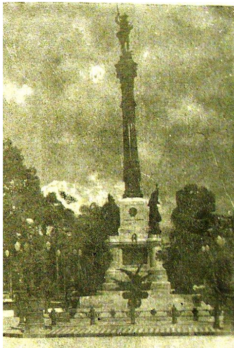
Figura III - Monumento ao 2 de Julho de 1823, inaugurado em 1895. Fonte: Rev. IGHB, n. 48, 1923.
