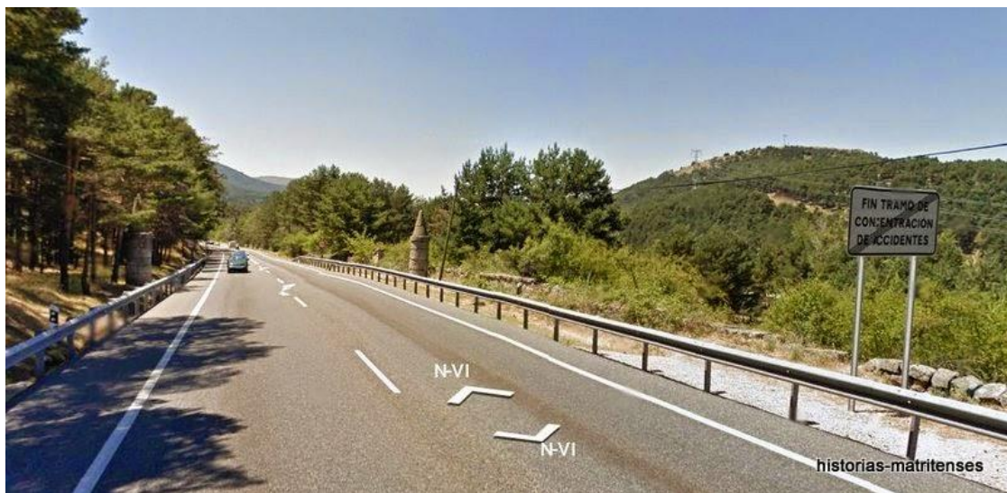
Los Picutos, par nº 2, en San Rafael antes de Las Puenteillas vistos desde el lado Madrid. Google
