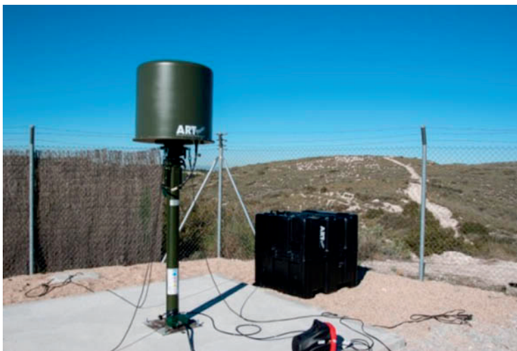
Figura 15. Instalación del radar en las instalaciones del ITM. Fuente: Boletín de Observación Tecnológica en Defensa n°44. SOPT.
