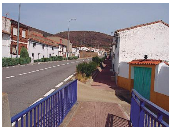
Fig. 14.- Circunvalación de la carretera N-630 en la calle de San Benito
