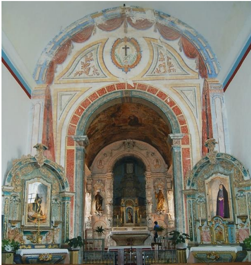
Figura 7. Cobertura da nave e capela-mor (abóbada de berço).
