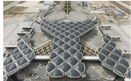
4f. Geometrías de la cultura árabe (Aerop. Amán) http://arqa.com/arquitectura/internacional/aeropuerto-queen-alia-en-amman-jordania.html
