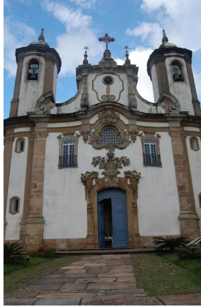
Figura 1: Vista da fachada principal Igreja da Ordem Terceira de N. Sra. do Carmo de Ouro Preto Fonte: Lia Sipaúba 23/03/2013
