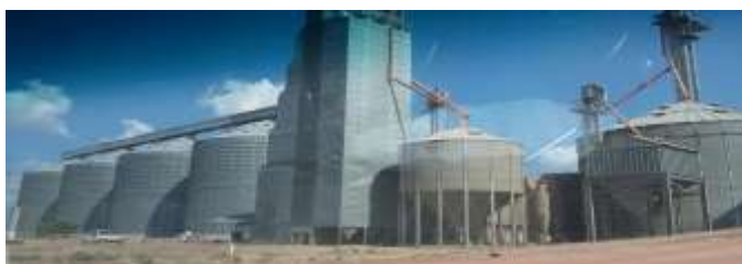
Fotografia 01 - Estrutura de Armazenagem da Cooperativa Grão Norte
